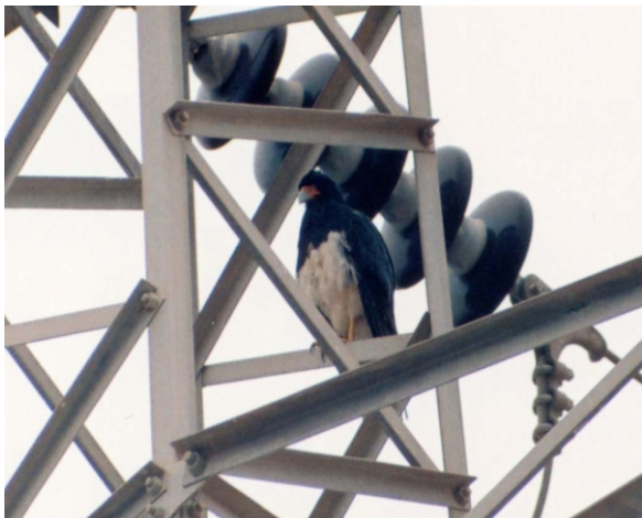
Figura 2. Ejemplar de P. megalopterus vigilante en la torre de tendido eléctrico en Proter, 20 de octubre del 2009 (Jhonson K. Vizcarra).
