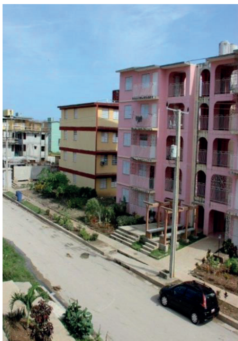
Figura 2. Edificio multifamiliar donde se realizaron las pesquisas.
