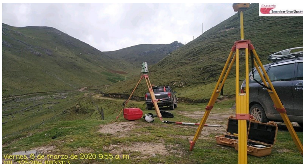
Figura 3 Construcción de la poligonal principal de apoyo
