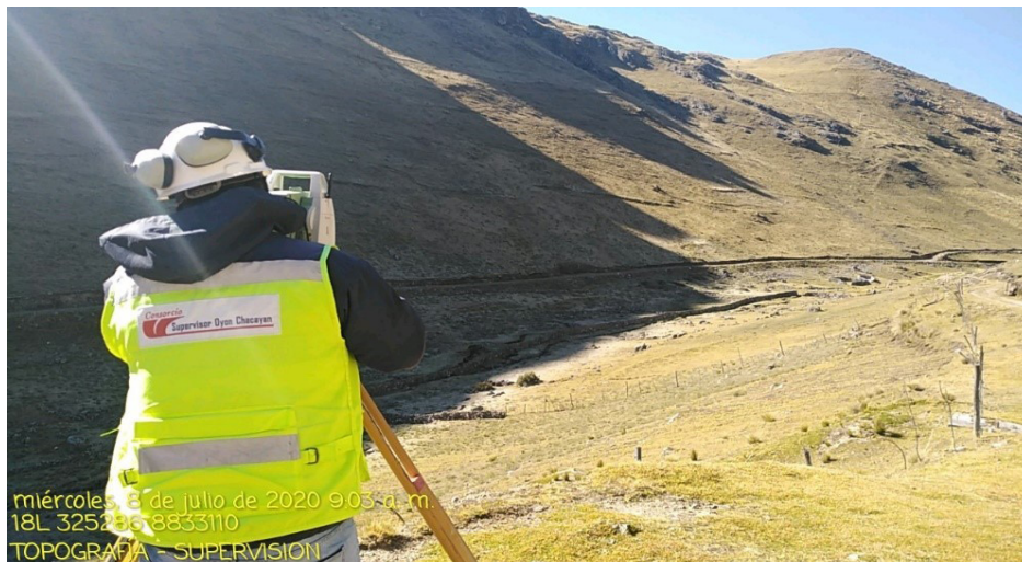
Figura 4 Levantamiento topográfico de la cantera Llicllao
